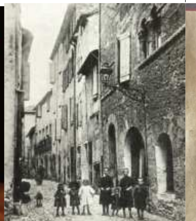
Esta casa medieval del número 55 de la calle Peyrollette ha perdido el vano geminado y el cordón decorativo pero conserva las grandes arcadas de la tienda de la planta baja.
